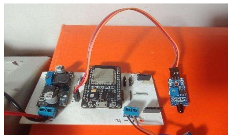
Gambar 21 Pemasangan sensor IR Flame
