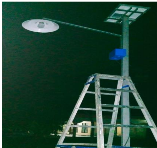
Gambar 1. Set Up Pemasangan Lampu Sistem Panel Surya.
