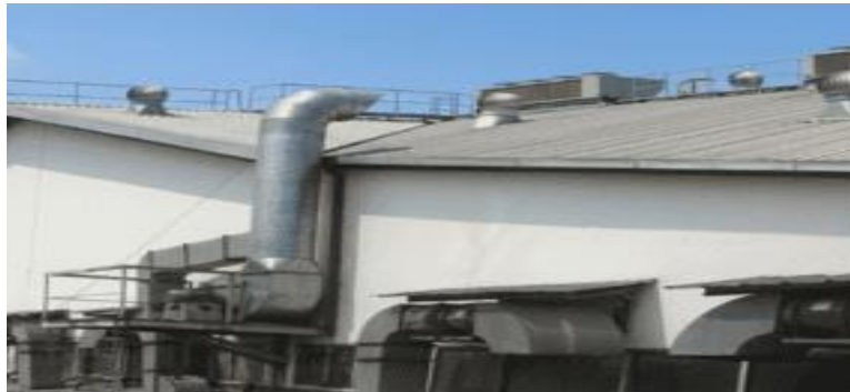
Gambar 3. Pemasangan Sistem Ducting Vertikal.
