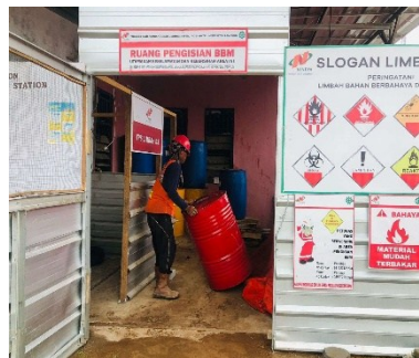
Gambar 5. Penyimpanan Limbah B3 Proyek
